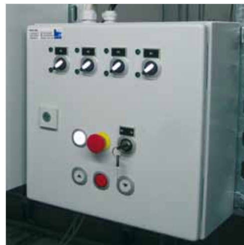
Basic Control – Bürgerhaus, Unterföhring
